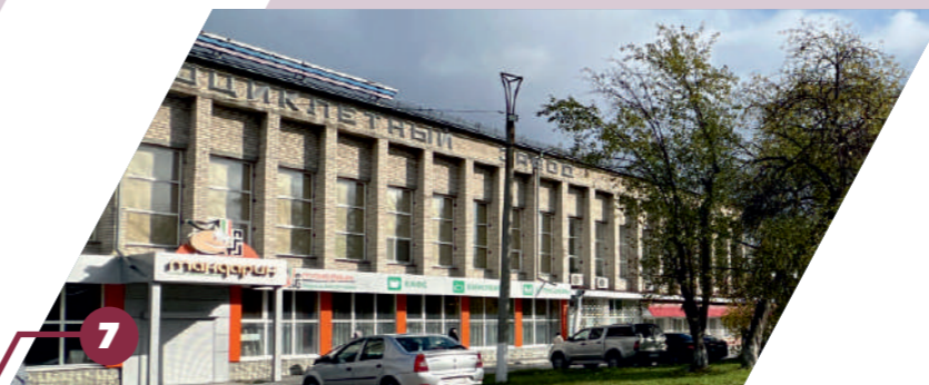
Состояние окружающих построек в архитектурно-художественном отношении неудовлетворительное. Фасады АБК, изначально невыразительные, увешаны пёстрой рекламой
