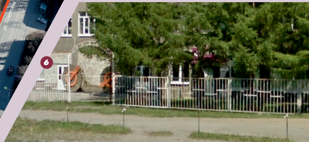
Ограждения добавляют визуального шума, портят общий вид
