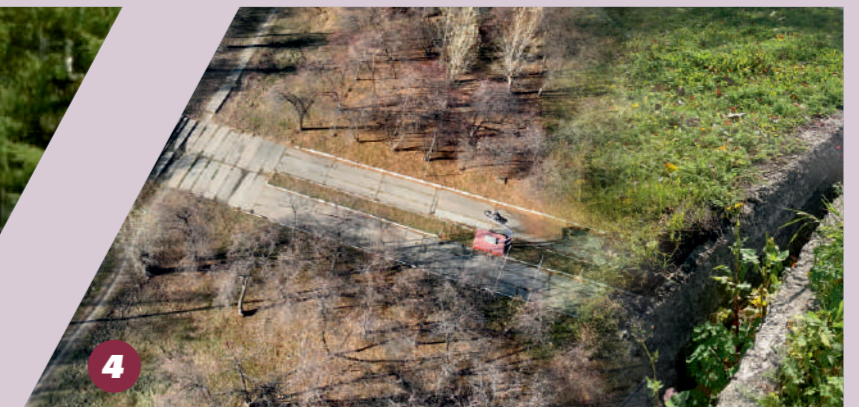
Мощение, открытые лотки ливневой канализации
