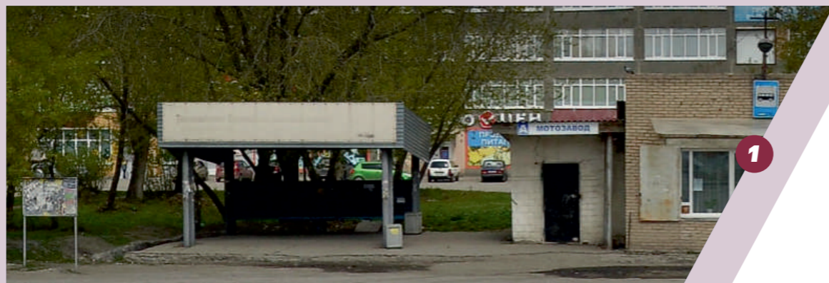
Остановочный комплекс требует реконструкции
