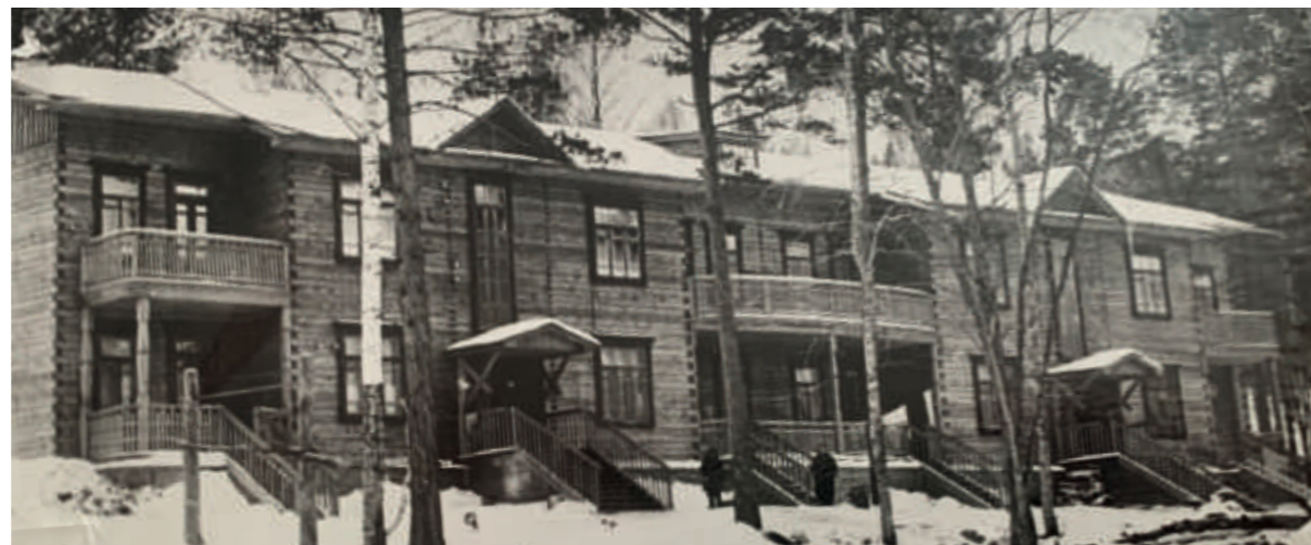
Деревянные шахтёрские дома – «баракы» района Старого Соцгорода
