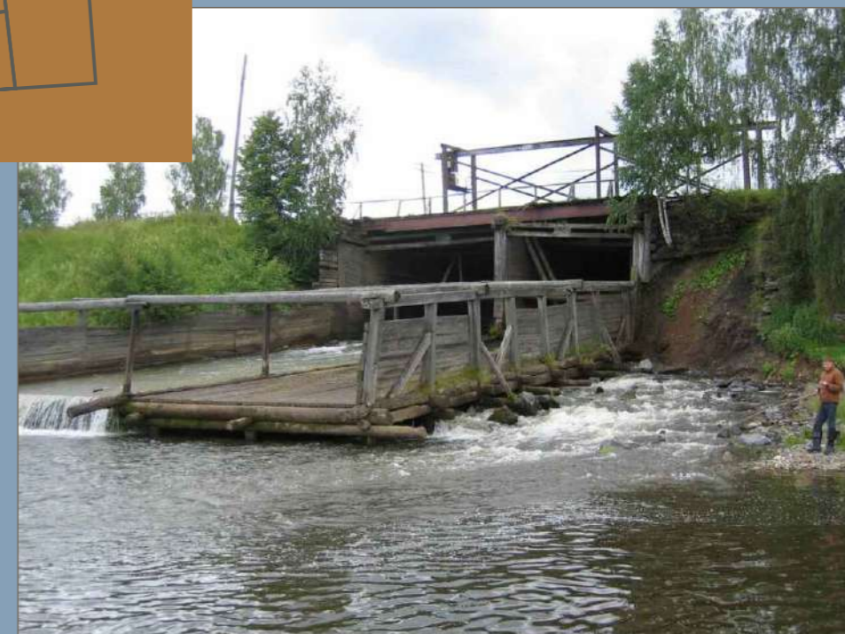
Деревянная заводская плотина Березовского
